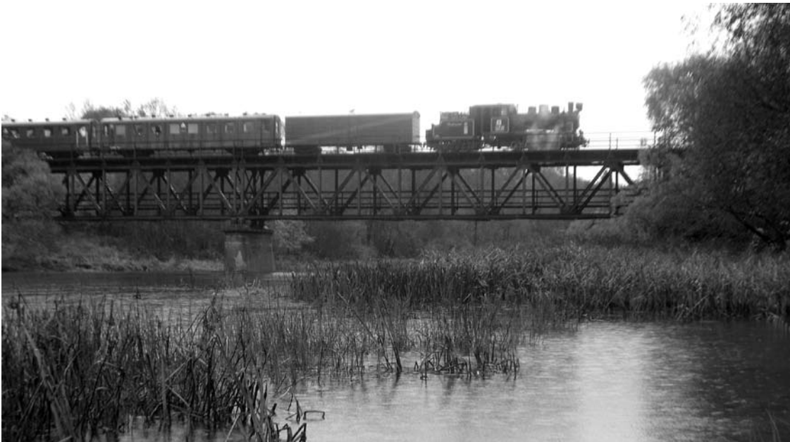
Geležinkelio tiltą per Šventąją galima laikyti vienu unikaliausių Anykščių statinių.
